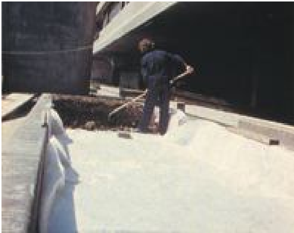
空中花園不織布鋪設中
