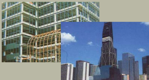
鋼板複合樓板大樓
